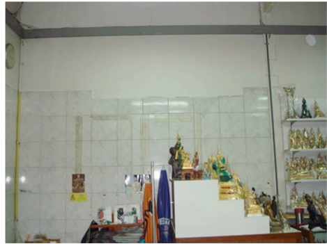
ผนังภายในอาคาร
