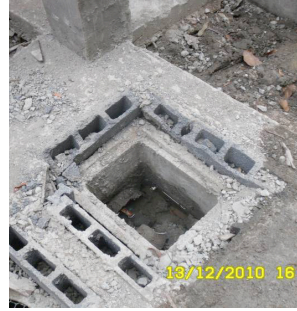
การติดตั้งบ่อพักไขมันเพิ่มเติม
