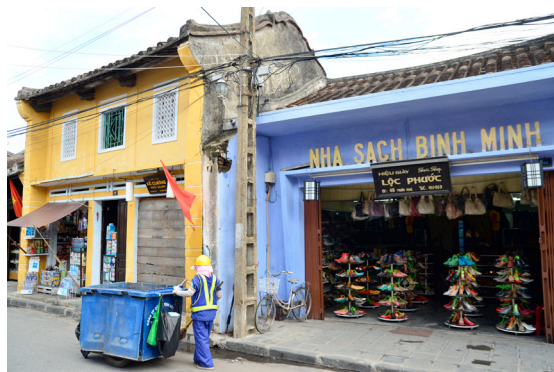
อาคารในบริเวณเมืองเก่าที่มีใช้ไม่จะเห็นการทาสีอยู่เพียง ๒ สี เท่านั้น คือ สีเหลืองและสีฟ้า
