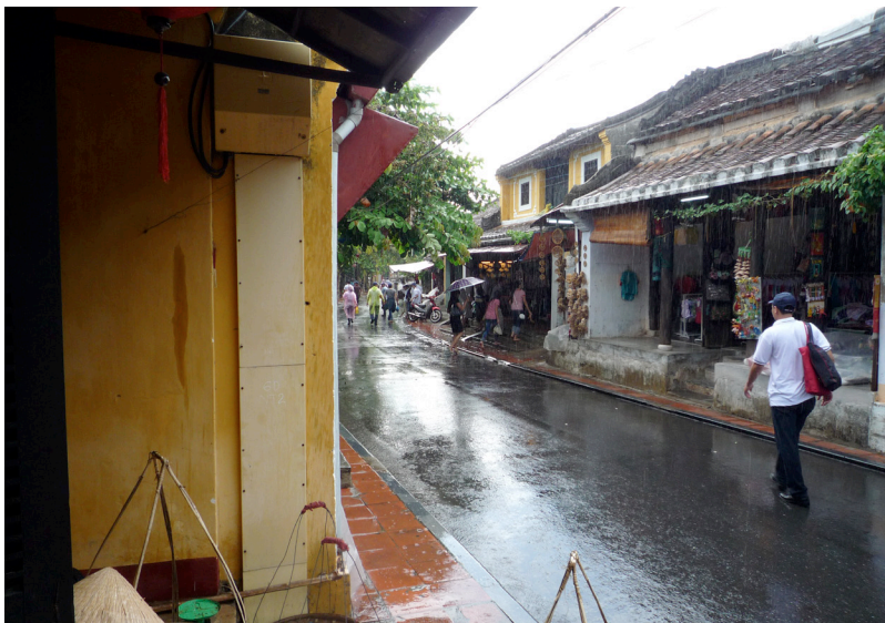
ในบริเวณเมืองเก่ามีการนำสายไฟฟ้าลงดิน โดยจะสังเกตเห็นได้จากแต่ละอาคารจะมีการเดินสายไฟฟ้าขึ้นจากดินสู่หม้อแปลงเพื่อใช้ในอาคาร
