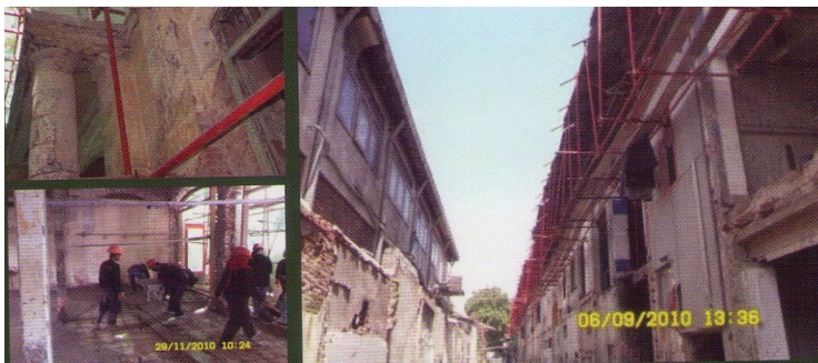
การดำเนินงานปรับปรุงซ่อมแซมอาคาร
