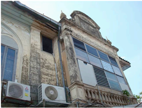
ผนังภายนอกอาคาร
