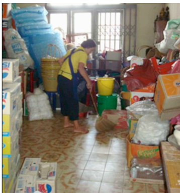
สภาพพื้นก่อนการบูรณะอาคาร
