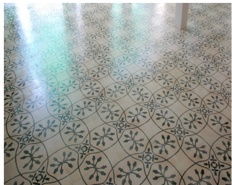
สภาพพื้นภายหลังการบูรณะอาคาร
